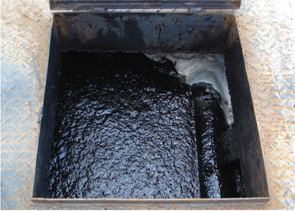
Рисунок 5 – Отстойный резервуар с только что смытыми нефтеостатками
